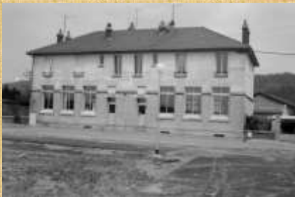
Ecole rue de Flandre
