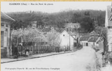
Rue du Pont de pierre – vers 1910
